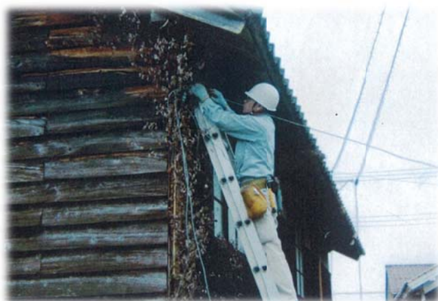
有線放送の改修
