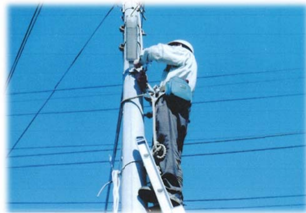
LED防犯灯の設置
