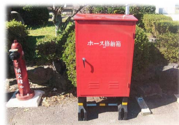
ホース格納庫の改修
