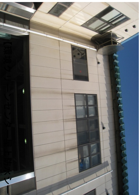
【環境クリーンセンター外壁】
