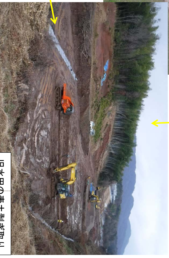
地下水の排水用暗渠管の設置
