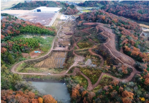
【敷地造成】 着工前
