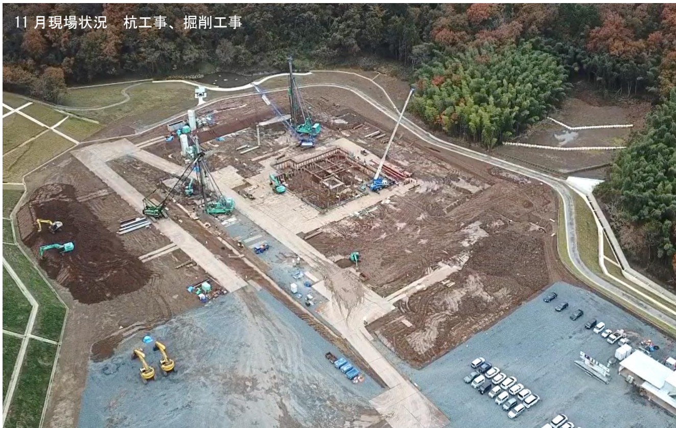
12月現場状況 杭工事、掘削工事
