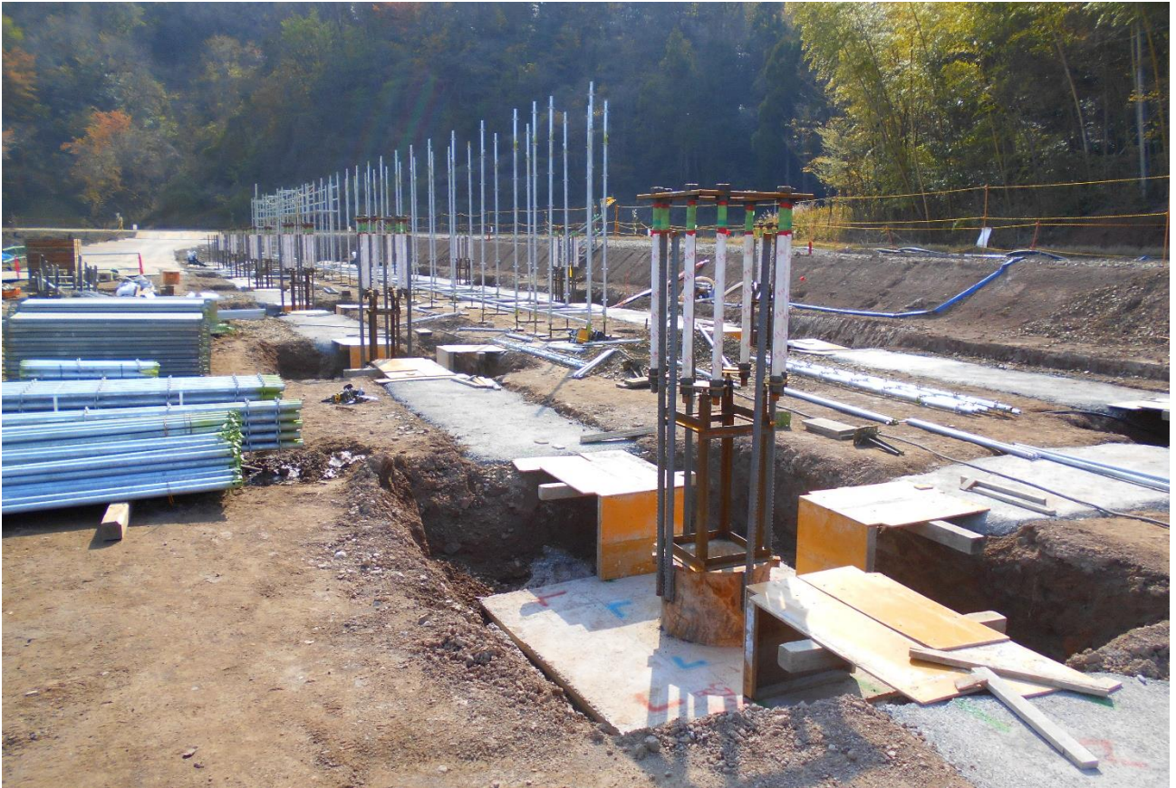
【入口側ランプウェイ基礎工事】
