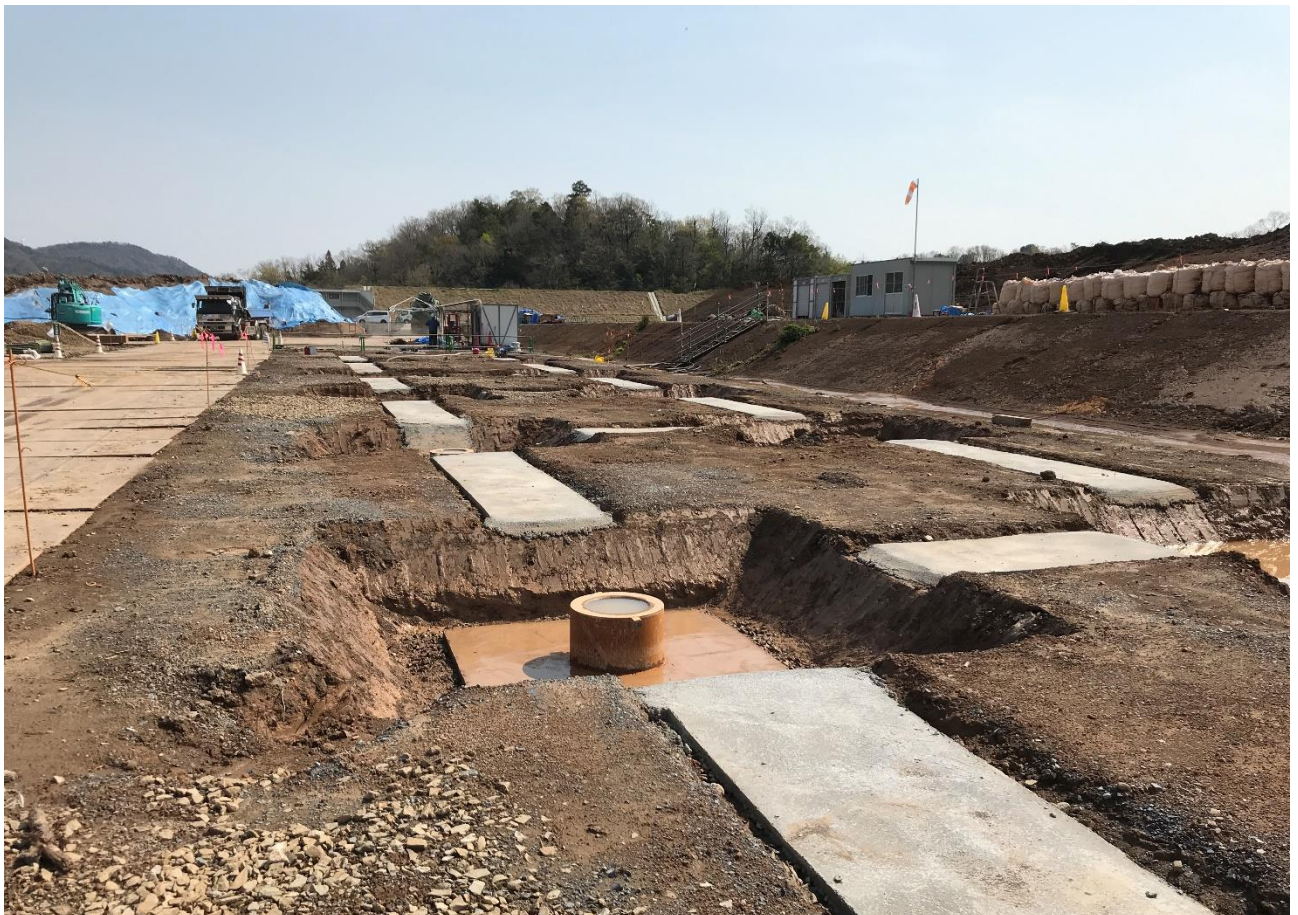
【出口側ランプウェイ基礎工事】
