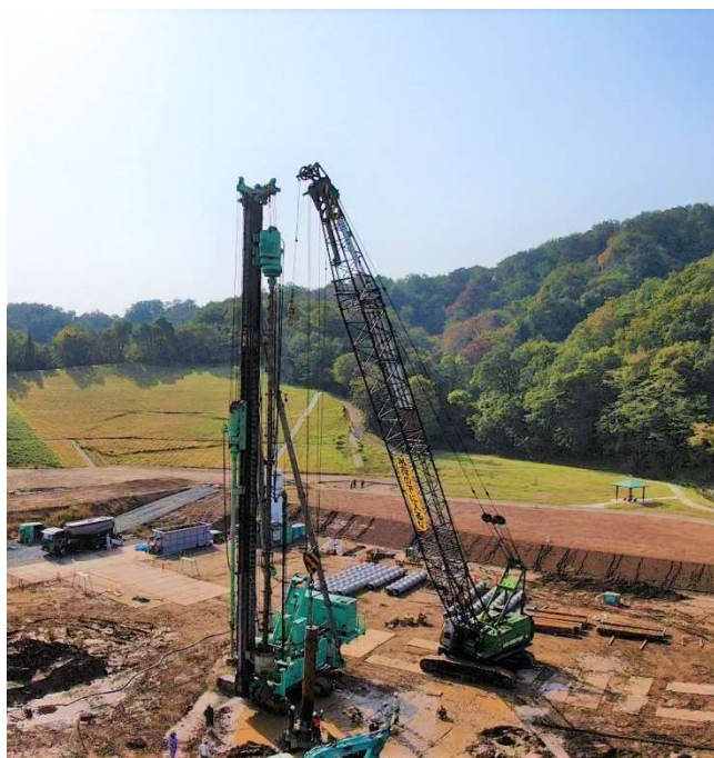
杭打設状況 全景
