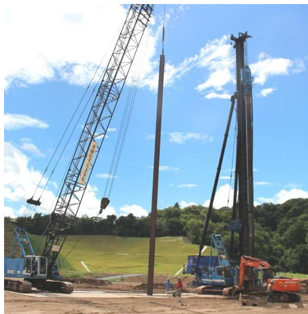
山留親杭・棚杭打設状況
