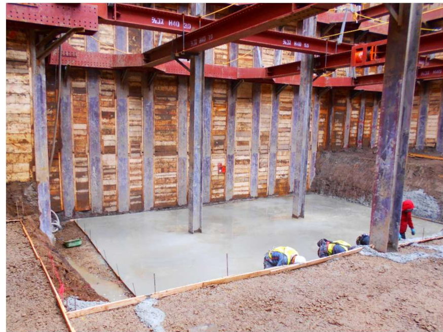
ごみピット掘削完了
