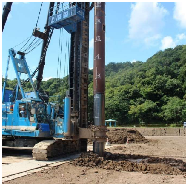
山留親杭・棚杭打設状況
