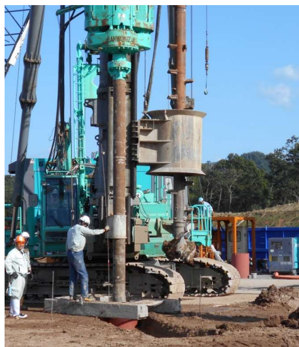
杭打設状況 掘削
