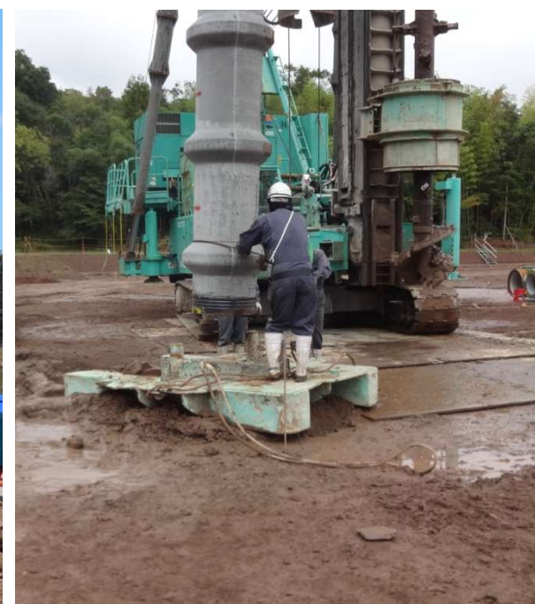
杭打設状況 下杭
