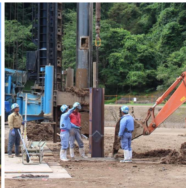
山留親杭・棚杭打設状況
