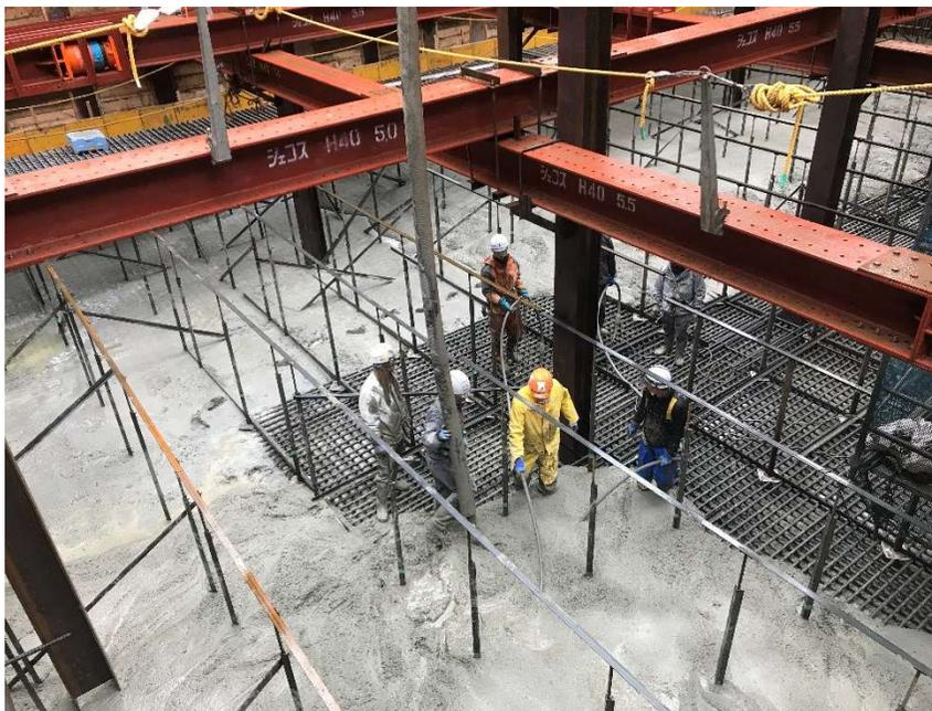
ごみピット底部コンクリート打設
