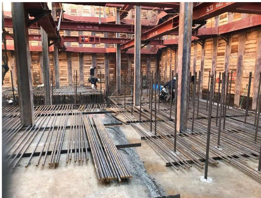
ごみピット底部鉄筋工事
