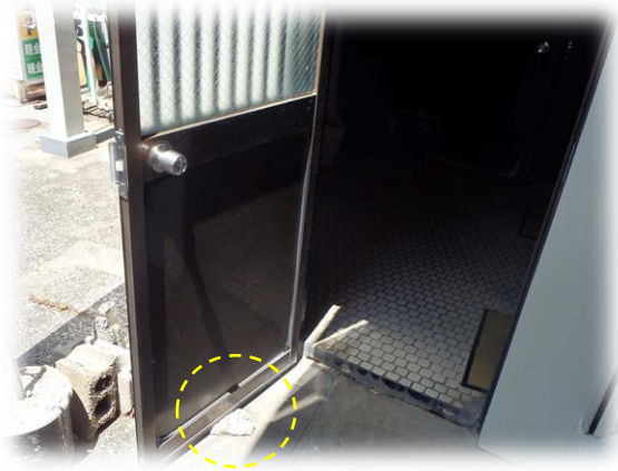
常時閉鎖が必要な出入口のドアに石を挟んだり、消火器を置いて閉まらないようにしている様子
