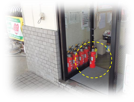
常時閉鎖が必要な出入口のドアに石を挟んだり、消火器を置いて閉まらないようにしている様子
