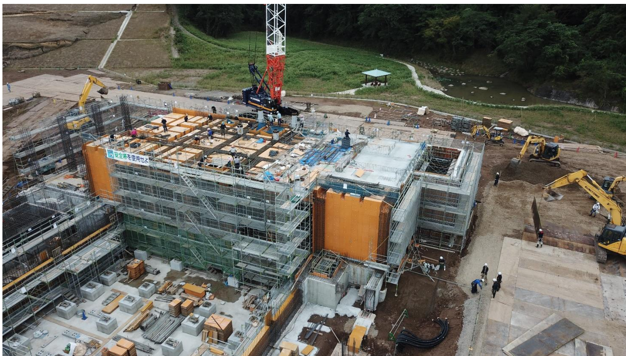
【排ガス処理エリア鉄筋工事】
