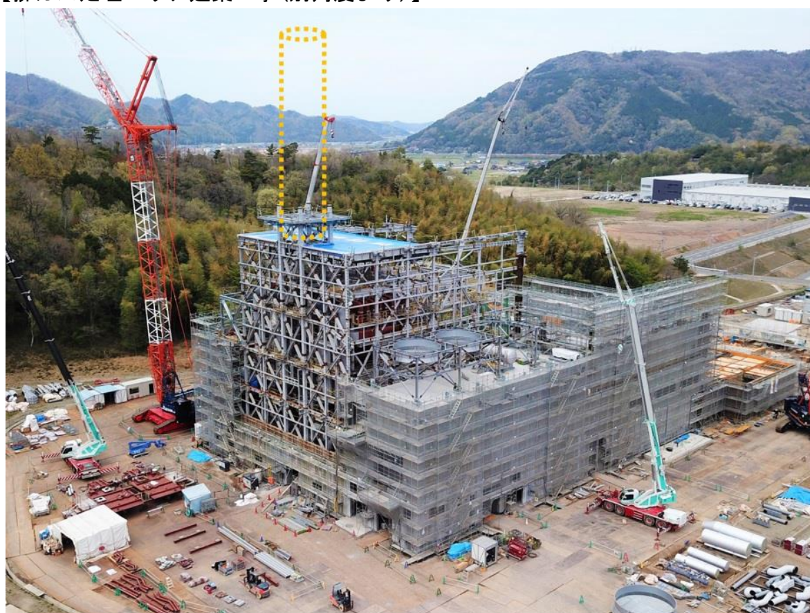
【排ガス処理エリア建築工事(別角度より)】
