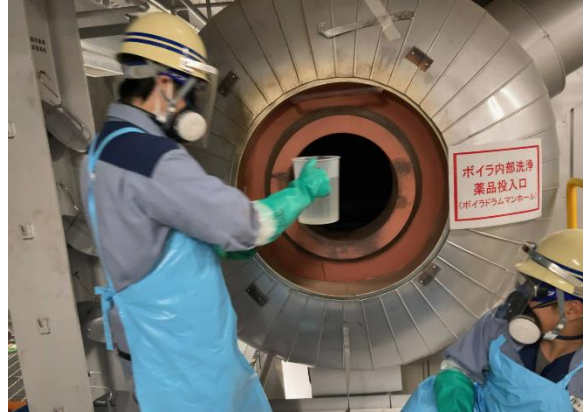
1月4日 ボイラ内部洗浄の薬品投入
