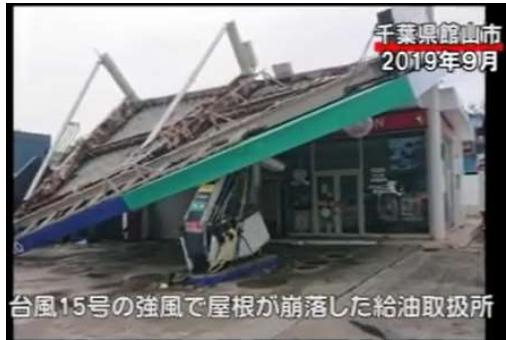
台風15号の強風で屋根が崩落した給油取扱所
