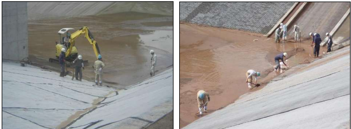
図 2.1.2-10 定期的な沈砂槽の堆砂除去の様子
