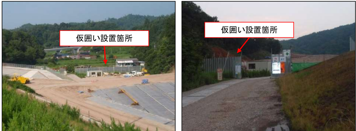
図 2.1.2-3 仮囲いの設置状況
