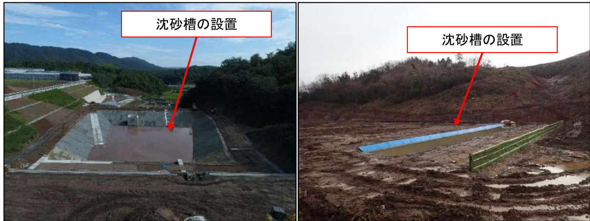
図 2.1.2-8 沈砂槽の設置状況
