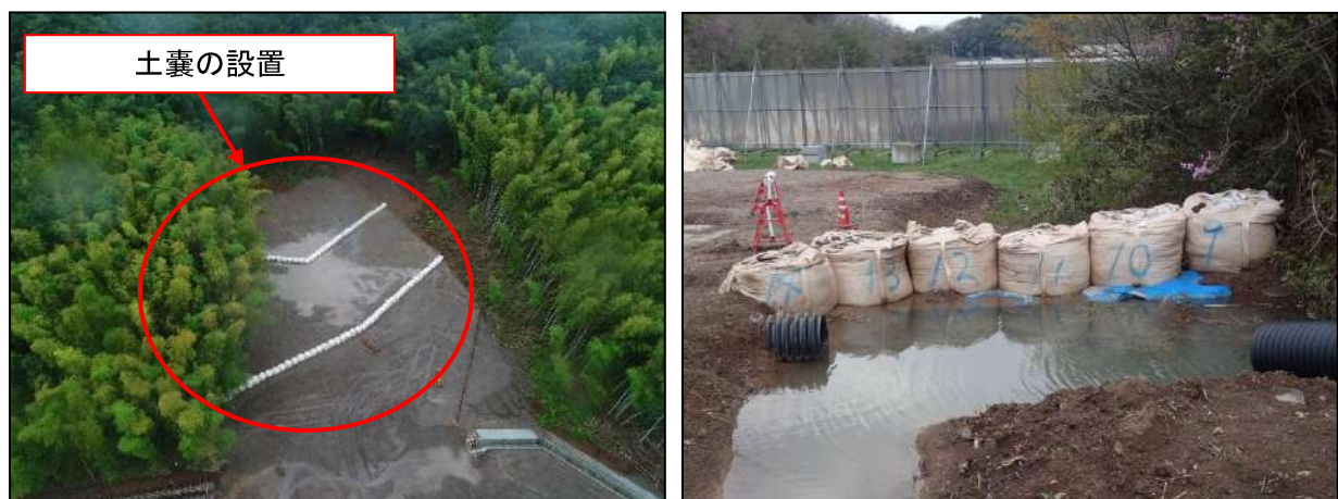
図 2.1.2-11 集中豪雨における土嚢の設置状況
