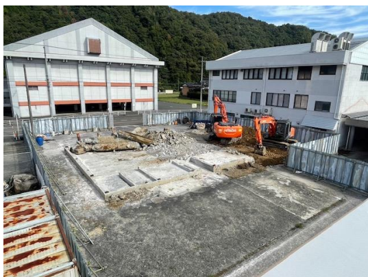
解体工事完了 R5.10.23
